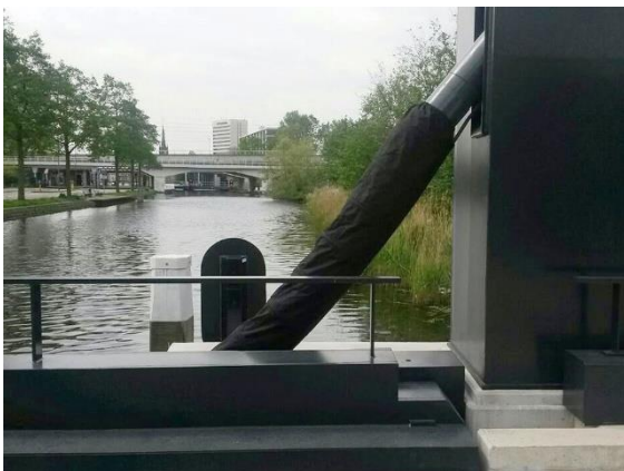
Protectores para cilindros hidráulicos elevadoras de puentes.
